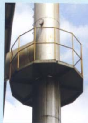
Gambar 11. Contoh posisi lubang sampling yang tidak sesuai dengan yang dipersyaratkan dalam Kepdal No.205 tahun 1996, lubang sampling berdekatan dengan elbow, yang seharusnya posisinya dari bawah 8 Diameter dari elbow dan 2 Diameter dari atas.
