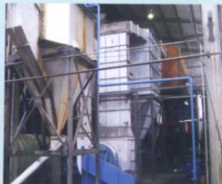
Gambar 2. Contoh peralatan pengendalian pencemaran udara jenis cyclone, pada boiler dengan bahan bakar batubara
