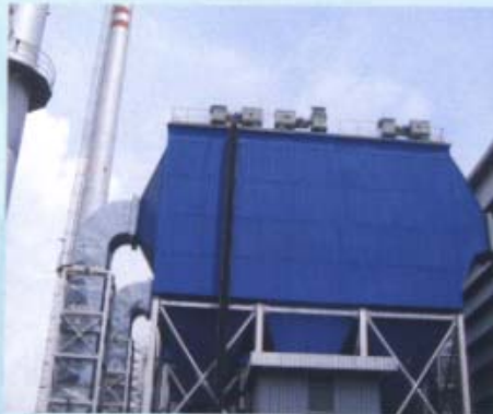
Gambar 1. Contoh peralatan pengendalian pencemaran udara jenis Electrostatic Precipitator, pada power plant dengan bahan bakar batubara
