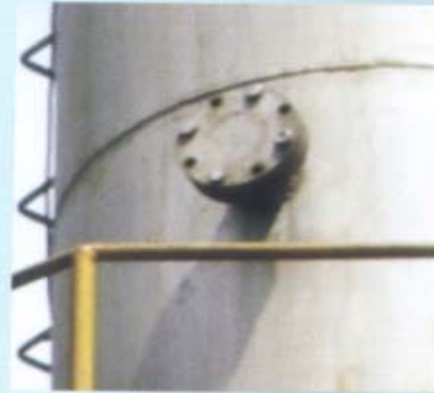
Gambar 6. Lubang sampel dgn penutup pelat flange
