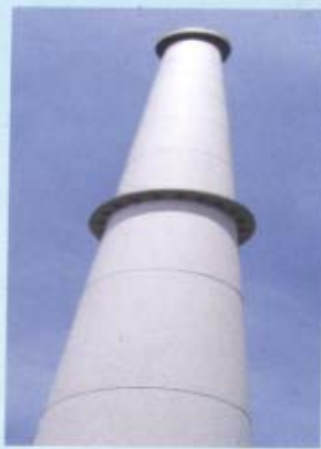
Gambar 10. contoh cerobong emisi udara yang tidak dilengkapi dengan sarana pendukung sampling
